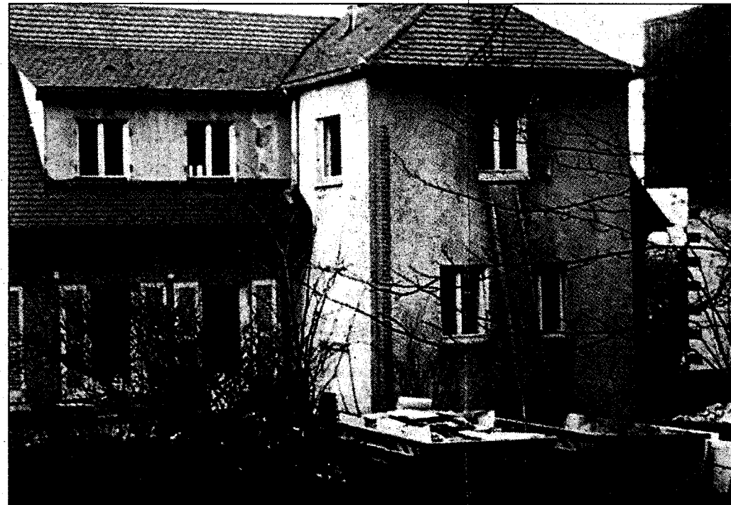
Gebäude älteren Datums verfügen meist über eine desolante Außendämmung.
